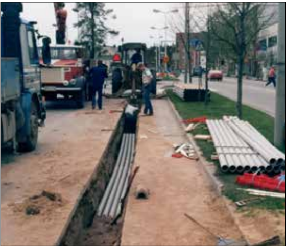
Lönnrotinkadulle asennetaan kaapeleita 1990-luvun puolivälissä suojaputken sisään.
